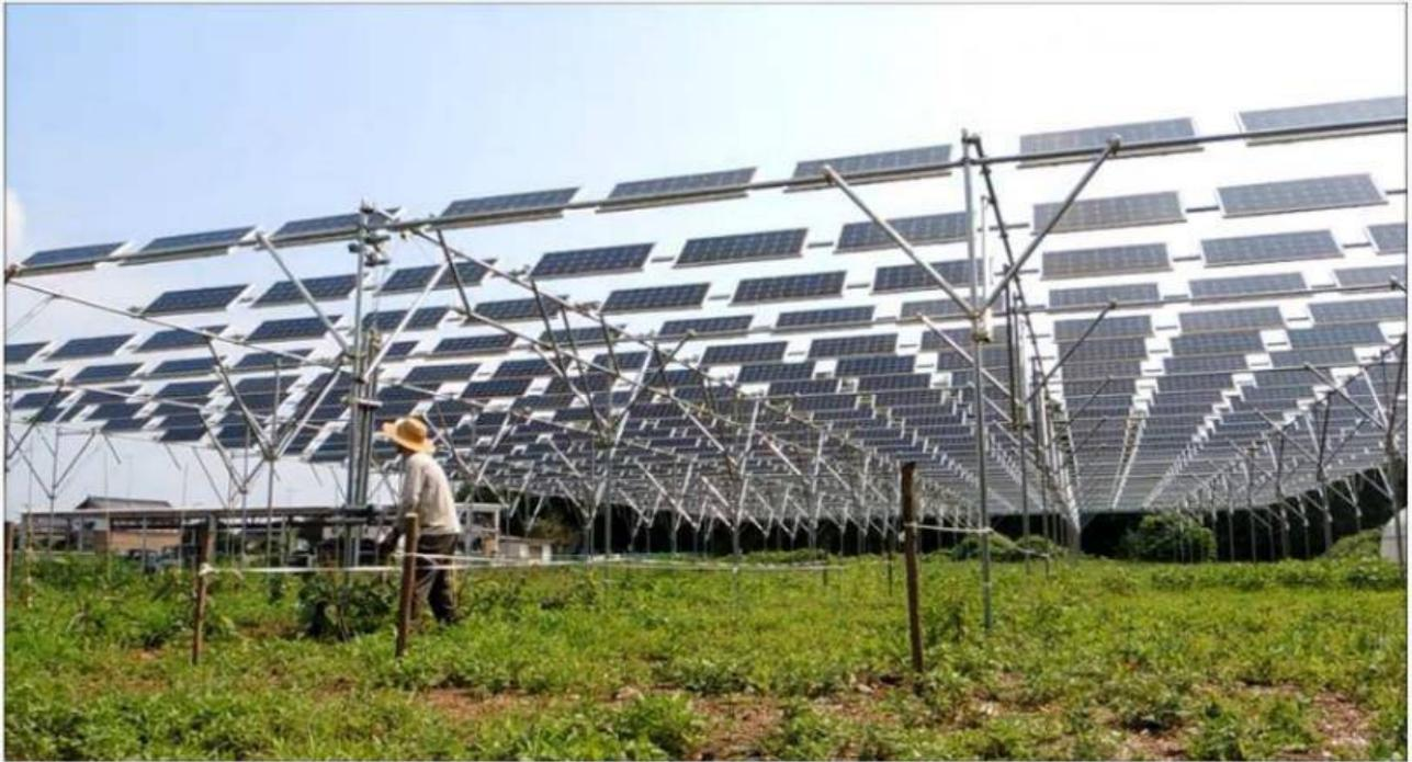
ソーラーシェアリング回動システム 100Wパネル579枚同時駆動
